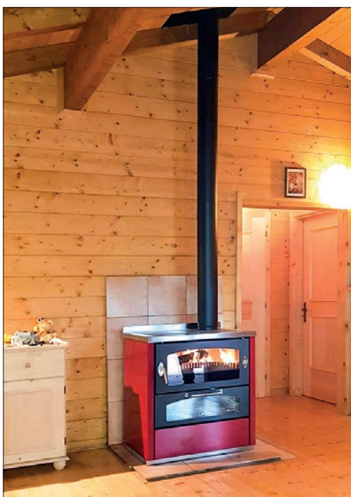
Realizzazione stufa/forno + modulo attraversamento tetto.
