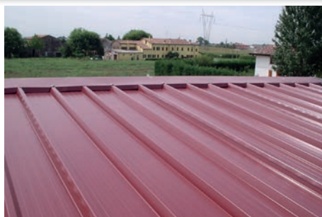
Alutech Dach acciaio prev. rosso Siena simil RAL 3009
