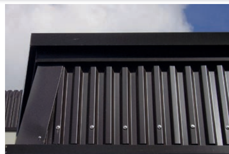
TEK 28 acciaio prev. testa di moro simil RAL 8017
