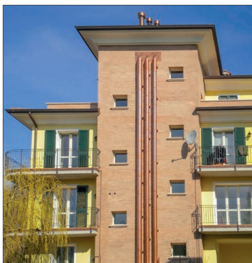
Realizzazioni su condominio con DP Rame
