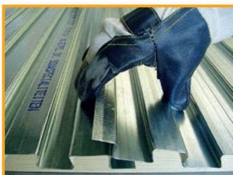
Sovrapposizione **longitudinale** delle lastre in appoggio
